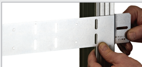
Vorgebogene Kante am C-Profil ansetzen
