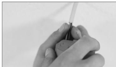
Öffnung für die Anschlussleitung in der Kappe (5) ausbrechen. Kappe (5) auf die Hohlraumdeckendose (6) aufrasten. Kabel in die Dose (6) führen und das System im Decken- oder Wandausschnitt durch Anziehen der seitlichen Schrauben befestigen.
