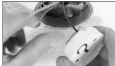
Führen Sie die Elektroinstallation mit dem FILUXX Systemkörper (7) durch, indem Sie die Kabel in die Vorrichtungen einstecken.
