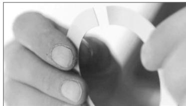
Setzen Sie den Kunststoffring (4) in die geschnittene Deckenöffnung (ø68mm) in die Hohlraumdecke ein.
