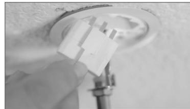
Hängen Sie nun die Leuchte an den eingebauten Haken des Systemkörpers und stecken Sie den Systemstecker (1) in den FILUXX Systemkörper (7).
