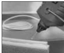
Colocar cables de teléfono.
