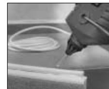
Colocar cabos de telefone.
