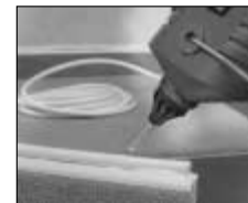
Trækning af telefonkabler.
