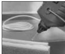
Pokladanie telefónnych káblov.
