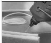
Montarea cablurilor telefonice
