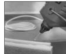
Posa di cavi del telefono.
