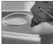
Puhelijohtojen kiinnittäminen.
