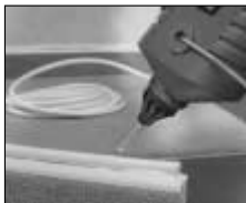
Прокладка телефонного кабеля
